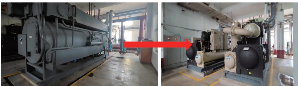
图 3 制冷机组节能升级更换
