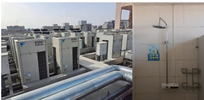
图 10 多联机更新改造项目和智能淋浴改造项目
