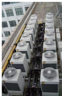
图 5 空气源热泵辅助太阳能加热
