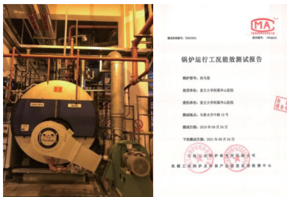
图 7 锅炉低氮改造
