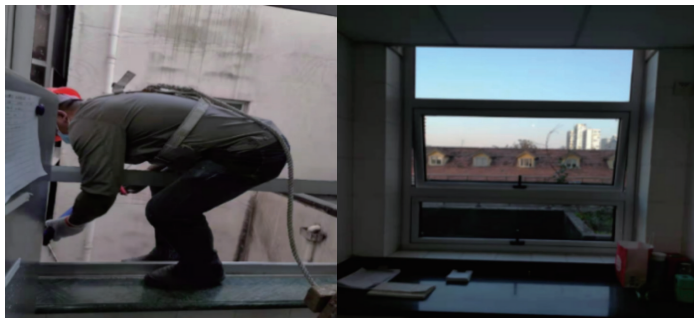
图 6 院本部 2 号楼 2F ~ 19F 北立面职工工作区域铝合金窗更换工程
