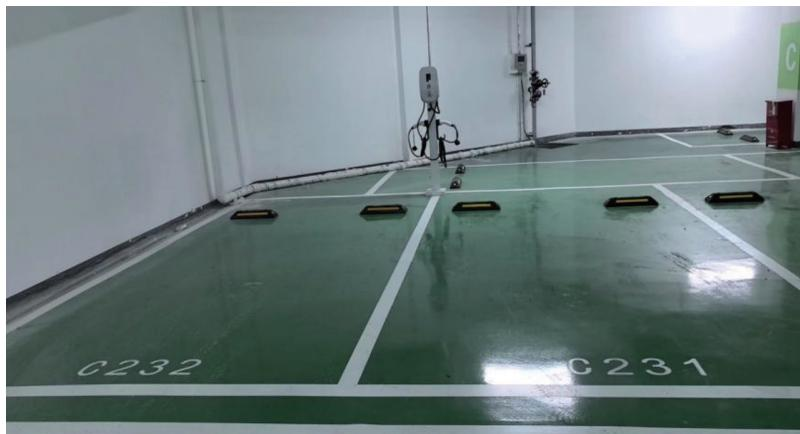
图3 地下停车场新能源充电桩
