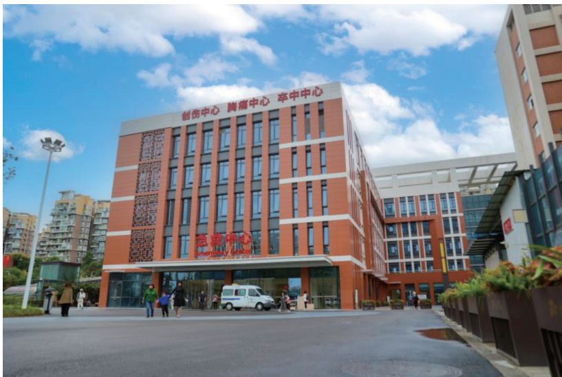
图2 南区急救中心和感染科大楼
