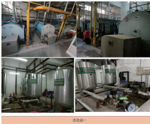
图 8 老旧高耗能高污染的燃气蒸汽锅炉（改造前）
